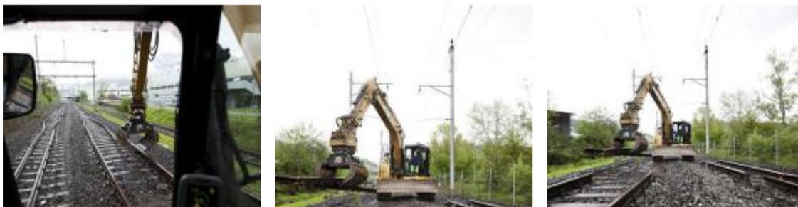
Die Schienen der zwei Kilometer langen Bahnstrasse zwischen dem Bahnhof Luzern und der S-Bahnhaltestelle Mattenhof kommen weg. Verrichtet wird die Arbeit von einem 16 Tonnen schweren Bagger. *(Bilder: Manuela Jans/Neue LZ)*
